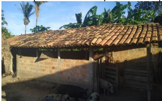
Figura 5 - Propriedade visitada no povoado de Jeniparana.
