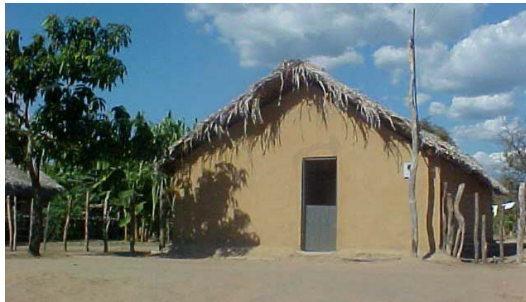
Figura 6 - Casa construída com tijolos de adobe em Porto Alegre do Piauí, PI.
