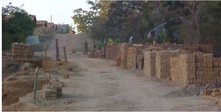
Figura 5 - Fabricação de tijolos de adobe as margens do reservatório de Boa Esperança, Rio Parnaíba, MA/PI
