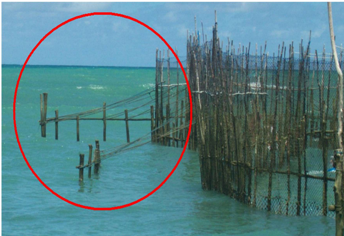
Figura 2. As camarras (destaque) são dispositivos que dão sustentação adicional às paredes dos currais de pesca do Estado de Pernambuco.
